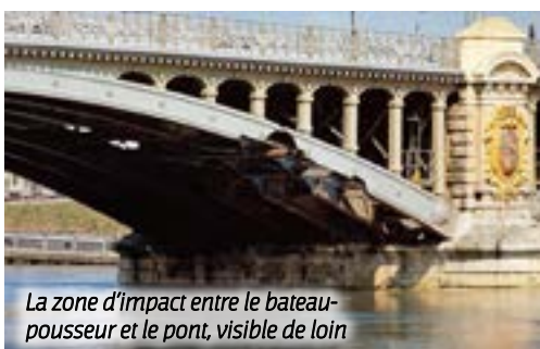
Les travaux de réparation ont duré plusieurs mois là aussi
